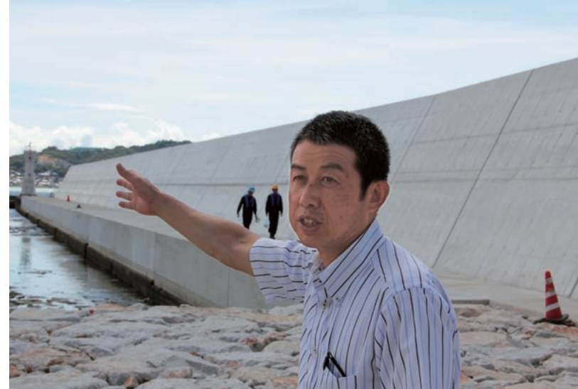
船尾地区側の防波堤の嵩上げはほぼ竣工している。「この嵩上げに加え、新たな鋼管矢板式防波堤を設置、その先に浮上式津波防波堤を施工し、港を守る計画です」と三村課長は語る。
