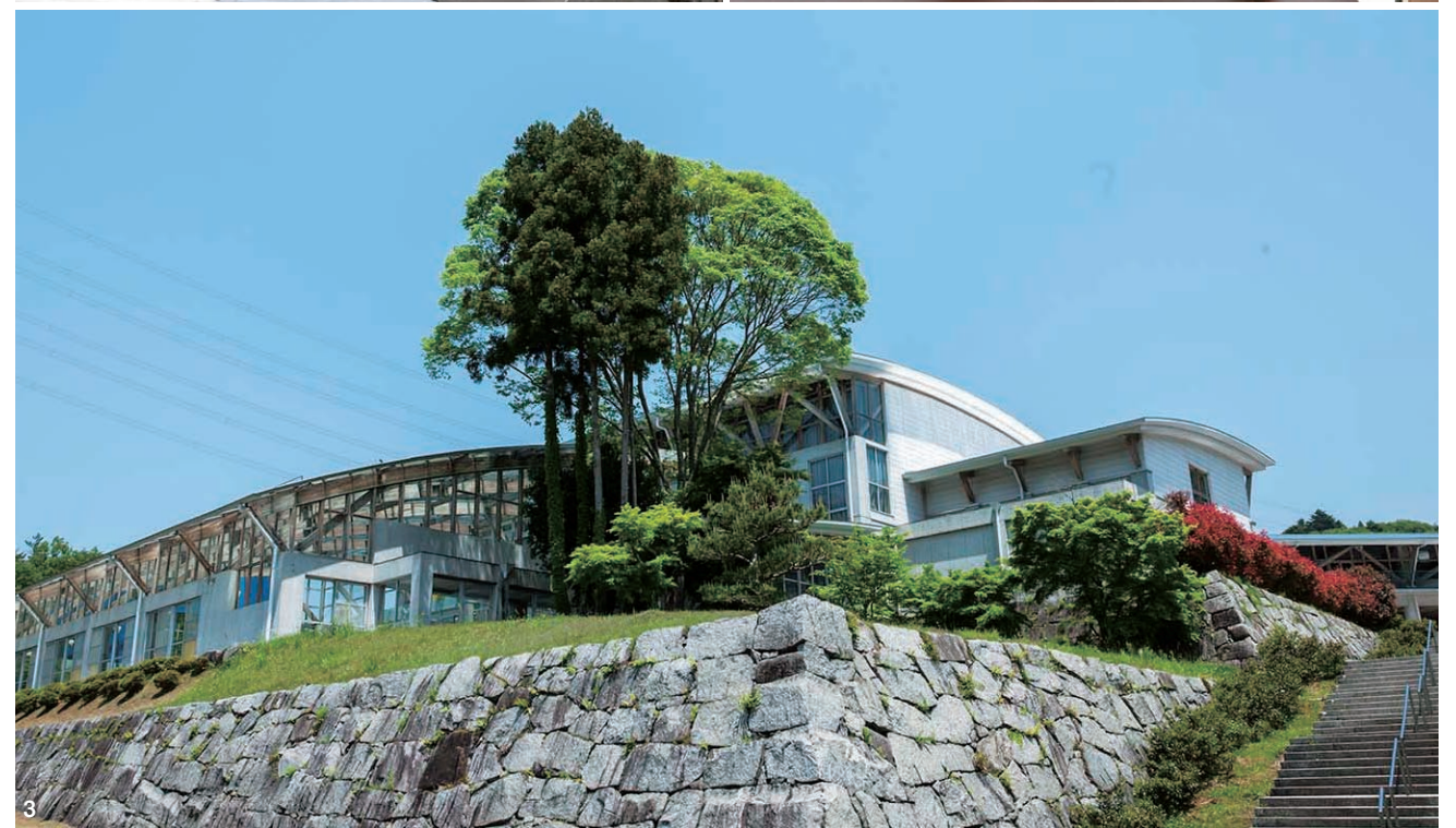
1 屋根を支える方杖。梁が大きくなり建物自体を圧迫させないために配された斜め材。下部のコンクリート柱に力をかけ、荷重が分散されるように設計されている。2 当校のこだわりの一つである木製サッシ。自然を見る際にも違和感なく、額縁のように外の空間を切り取っている。3 造成の際に出た岩塊を加工した石垣。プール棟の横の木は造成する前からの樹木を利用したもの。(写真：山田新治郎)
