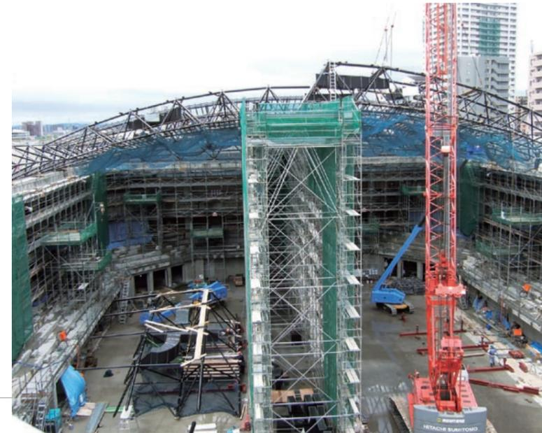
屋根の鉄骨トラス建て方の様子。建て逃げ方式で建てられている様子がわかる。赤い塔のように見えるのが、90tのクローラークレーン。(提供：佐藤工業株式会社)
