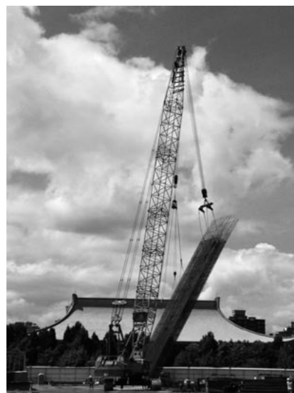
地中連続壁の構築
