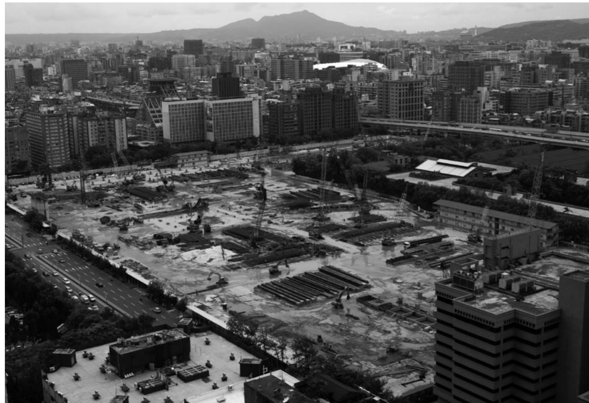
工事現場（全景）
