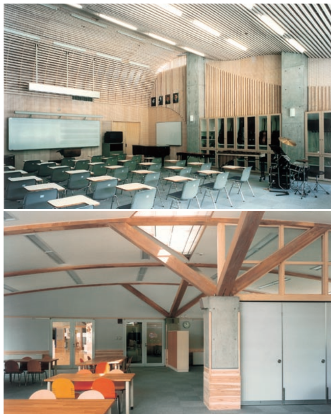
上／天井や壁に木材が多用されている音楽室。天井や壁には線状にカットされた木材を用いており、音響効果とデザイン性を高めた。それによって記憶に残る教室の一つになっている。下／屋根は木材によって支えられている。コンクリートの柱から、傘の骨組みのように木材が使われている。大きな柱で支えるのではなく、木材の温かさと開放性を活かした空間となっている。(写真：侘美孝昭)
