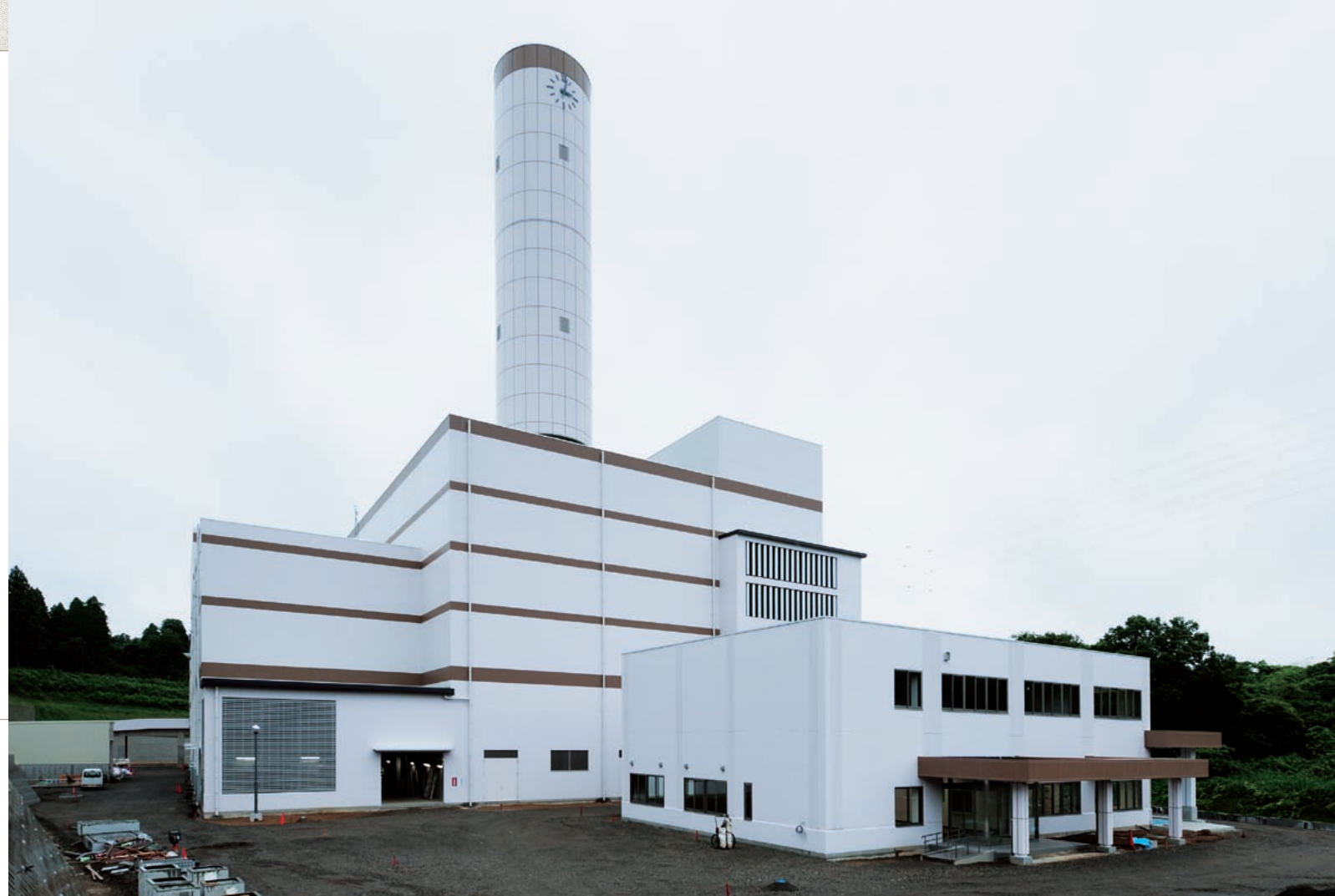
建物全景。写真手前側には管理棟、奥側には工場棟が見える。外壁は、景観に配慮し白系で統一されている。
