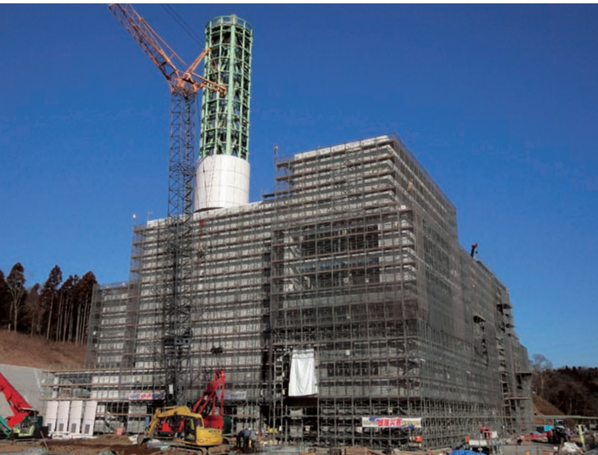
煙突の外壁工事におけるメタルカーテンウォール工法アルミ貼りの様子。煙突工事は、わずか1カ月半で完了した。(提供：株木建設(株))
