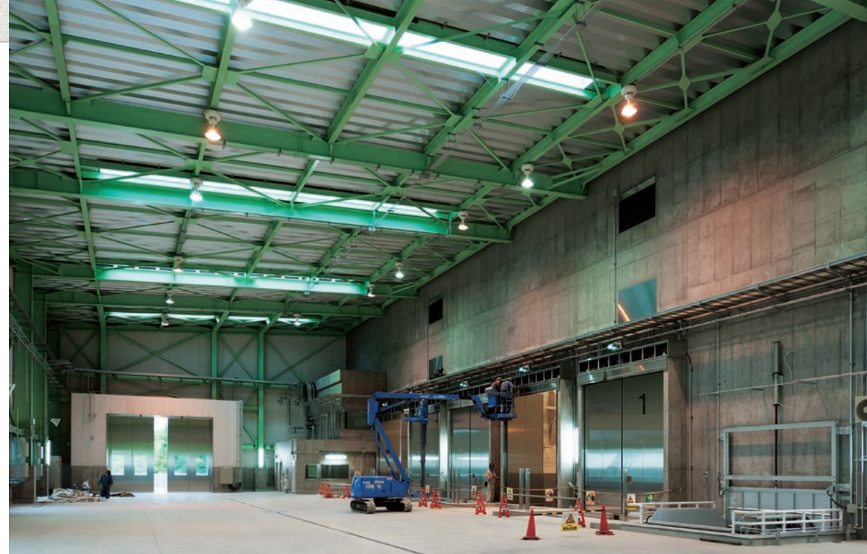
清掃車が集まるプラットフォーム全景。大スパンの空間が必要だったプラットフォームの屋根と壁のみ鉄骨造で施工されている。
