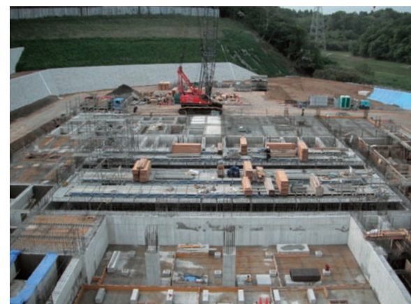
基礎コンクリートの様子。地下水の排出に配慮し、1日で1300㎡のコンクリートを打設した。(提供：株木建設(株))
