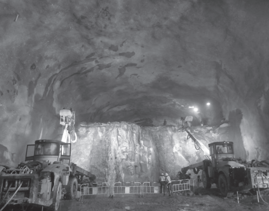
西營盤駅駅舎部下半掘削
