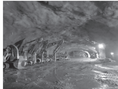
西營盤駅駅舎部上半掘削
