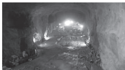
香港大学駅駅舎部全断面掘削完了
