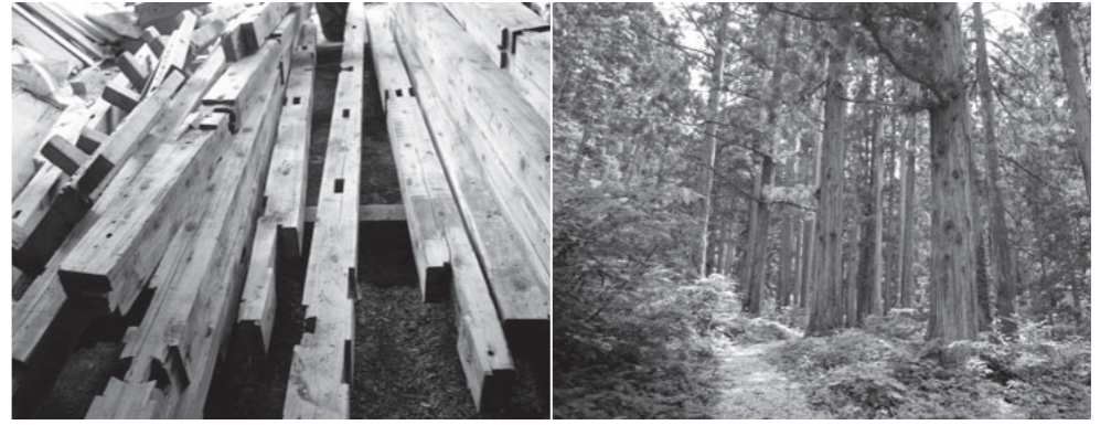
左/古い家屋を解体した木材。かなり年数を経たものだが、ほとんど劣化せず継手部もしっかりしている。釘を使わず木組みでたてれば、金山杉は驚くほど長持ちする。右/いずれも60m級と国内トップクラスの樹高を誇る「大美輪の大杉(おみのわのおおすぎ)」。樹齢最大280年だが、身がしまっているため幹の太さは2~3m程度だ。
