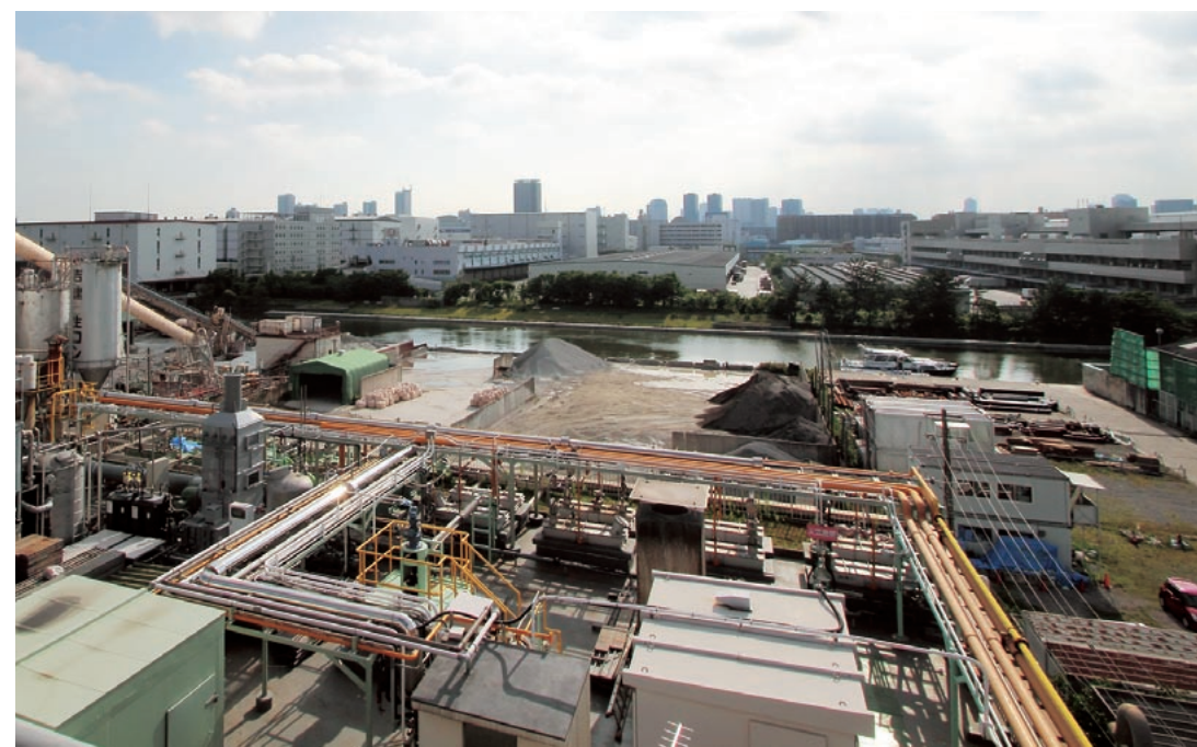
有機性廃水は廃水処理施設で処理される。脱水汚泥の段階で1/12、さらに乾燥によって1/4まで減量することが可能だ。
