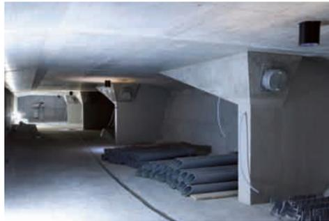
桁内部から見た斜材と主桁の定着部(写真下)。主塔から張られた斜材は橋面を貫通し桁本体に定着され外ケーブルとして橋桁を支える。
