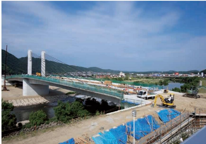
橋面上では最後の仕上げ作業が進む。歩道の幅は約4mと余裕がある。川面から12mの高さを吹き抜ける風が心地よい。
