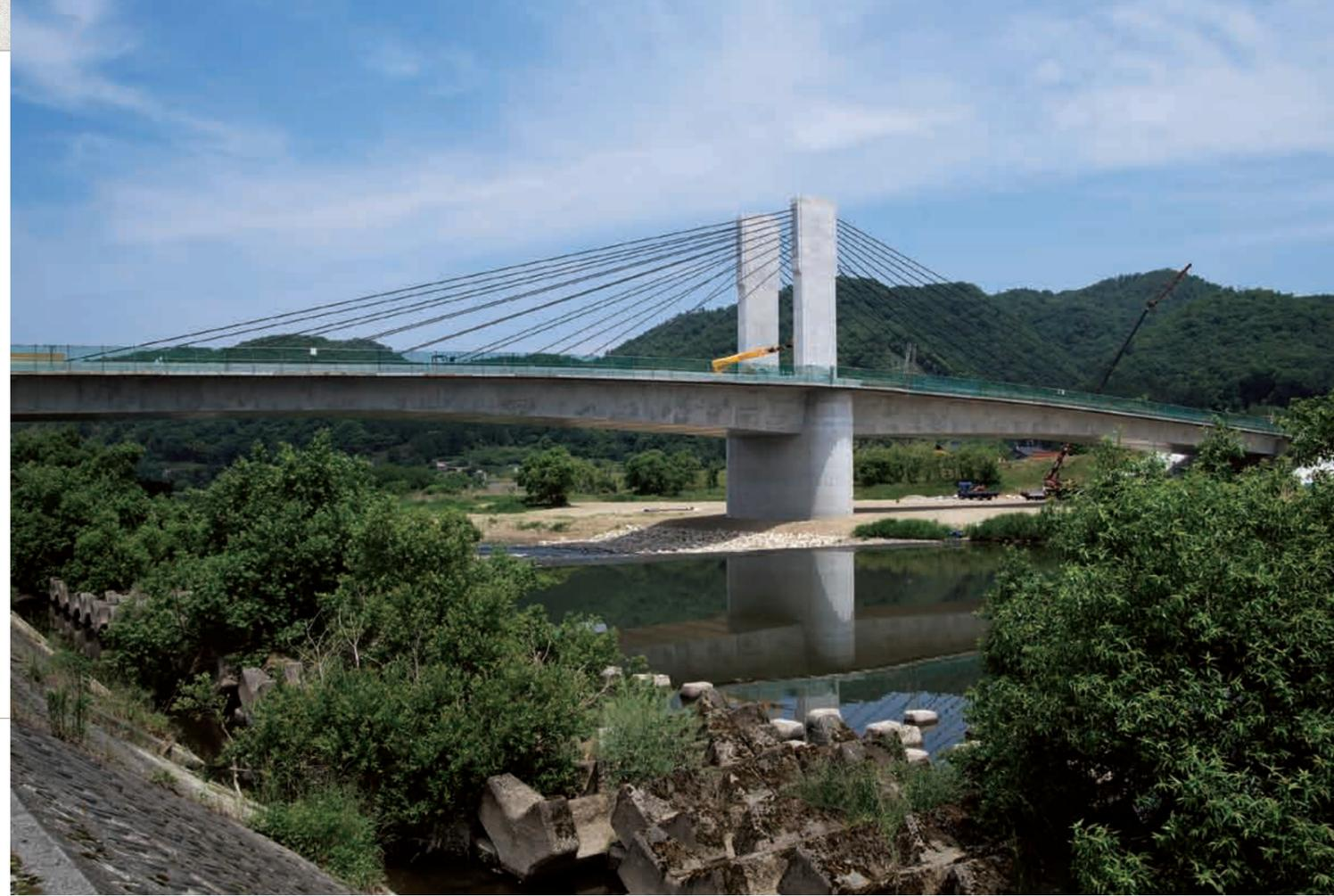
斜張橋に比べ主塔を低く抑えたため町の景観と一体となった(仮称)馬洗川橋。斜材の角度が水平に近く、交通荷重による斜材の応力振幅も低減される。
