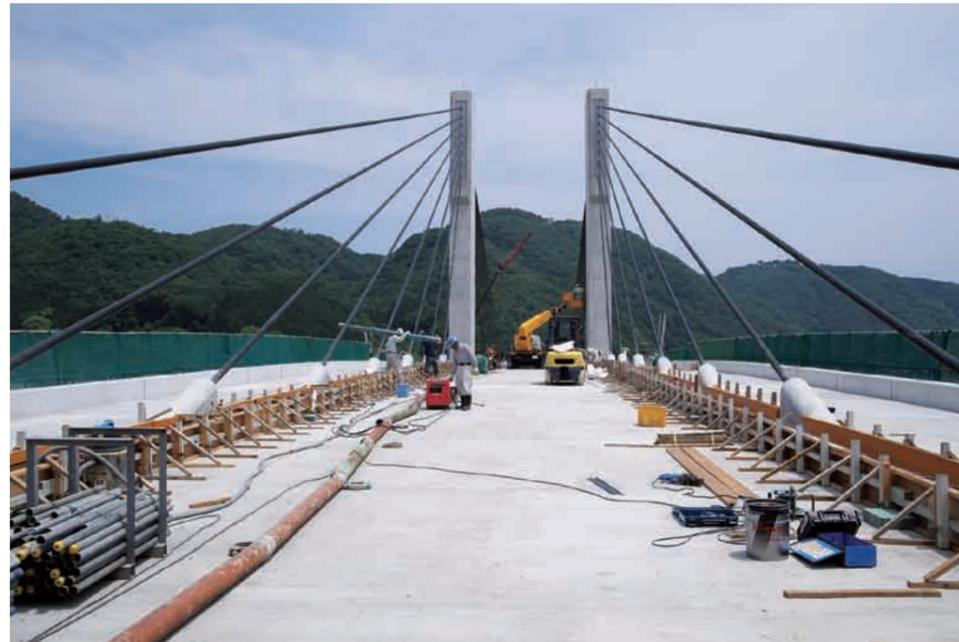
地上に刺した縫い針（主塔）に糸（斜材）を通し、その両端を固定して桁を支持する要領だ。それぞれ1本の斜材が主塔を跨ぐように貫通するサドル定着となっている。
