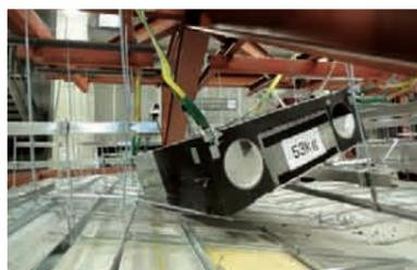
設備機器吊りボルト破断の様子
