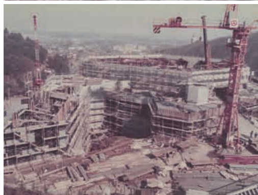
上／1階の基礎工事。複雑な地形での工事であったが、ここから段々と傾斜に沿って躯体が仕上がっていく。 下／工事中写真。躯体が建ち上がり、コンサートホールも並行して工事が行われている。
