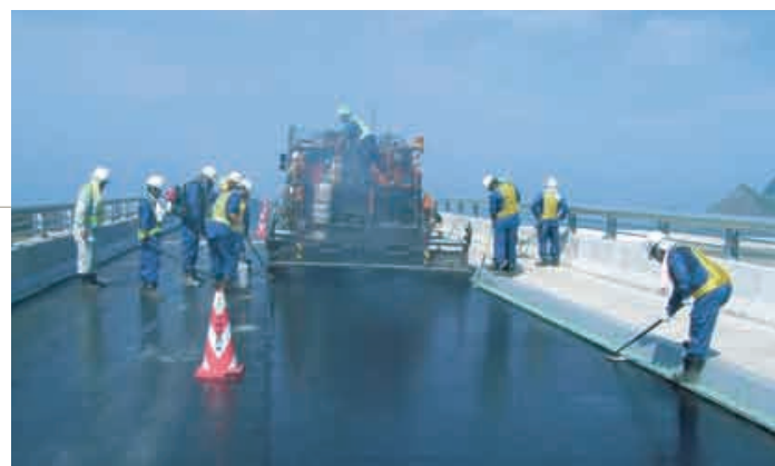
上／IH式舗装撤去工法は鋼床版のみを加熱するため、接触面を軟化させた舗装材をブロック状にしてバックホウで容易に剥離することができる。下／その後、流動性に富んだグーラスアスファルトを一挙に施工した。(写真提供：あおみ建設)
