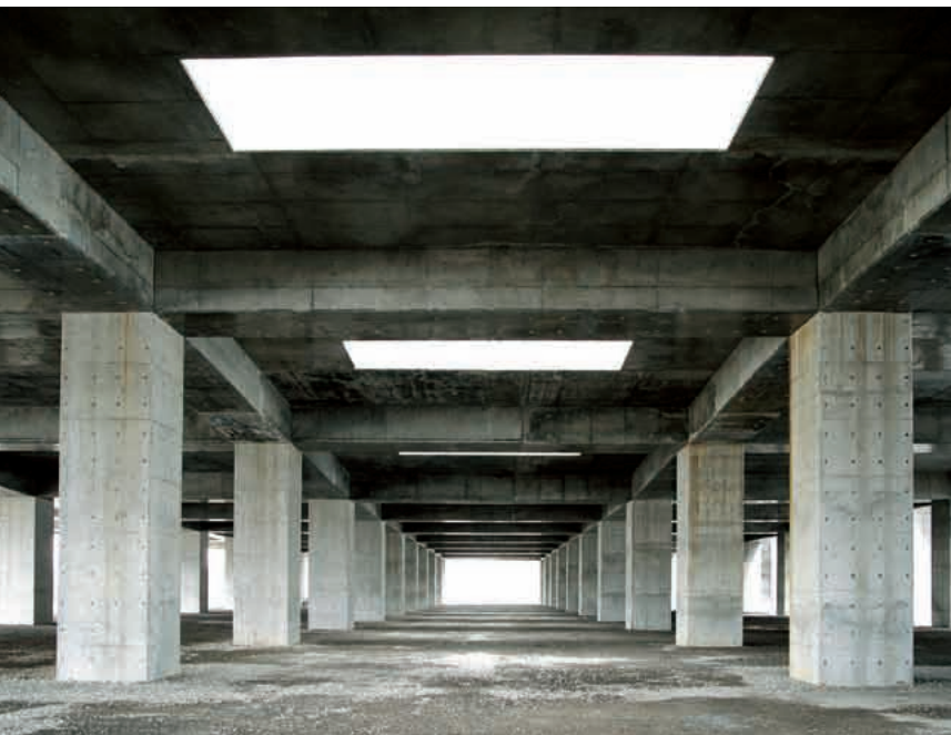
あおみ建設は採光のためのトップライトや階段室など人工島の施工も手掛けた。構造物に使用するコンクリートは当地の気候や海象を考慮し、その性能を厳密に検討した。
