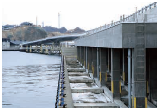
人工島の1階部分は漁業生産活動の場。前面の海域で養殖される水産物を厳格な衛生管理の下、水揚げ、出荷することが可能になる。
