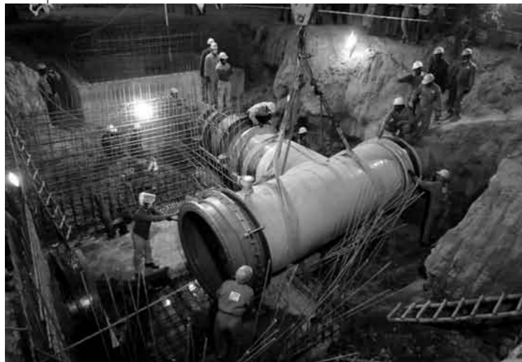
配水池における既設管路との接続状況
