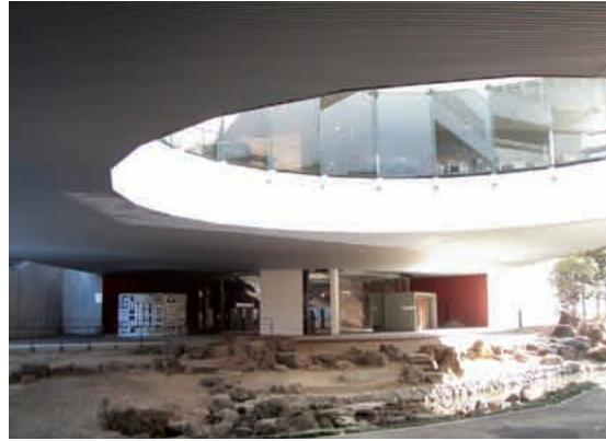
軒天井補修完了状況
