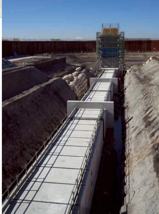
縦2.5m横4.6m奥行2.0mの函体41函を4～9函ずつ接合し、6基のブロックを造る。四角いドーナツを繋ぎ合わせた筒状のブロックをさらに連結してトンネル状にする仕組みだ。
