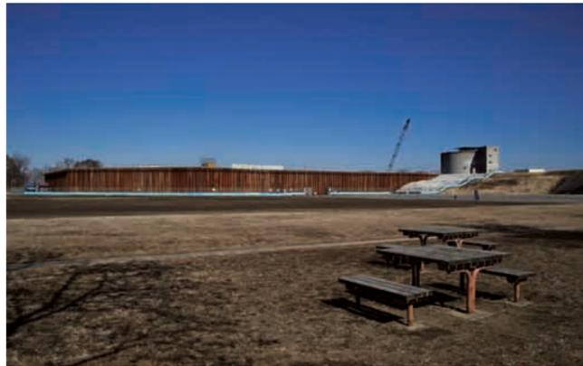
現場を包囲するように二重縮切工を築造。これは9m間隔で矢板を二重に打設し、その間に中詰土を充填した頑丈な仮設堤防だ。
