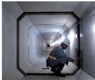
黒い枠がブロック間の接合部に施工された「可とう継ぎ手」。この継ぎ手が撓むことにより地盤の変位を一手に引き受ける。
