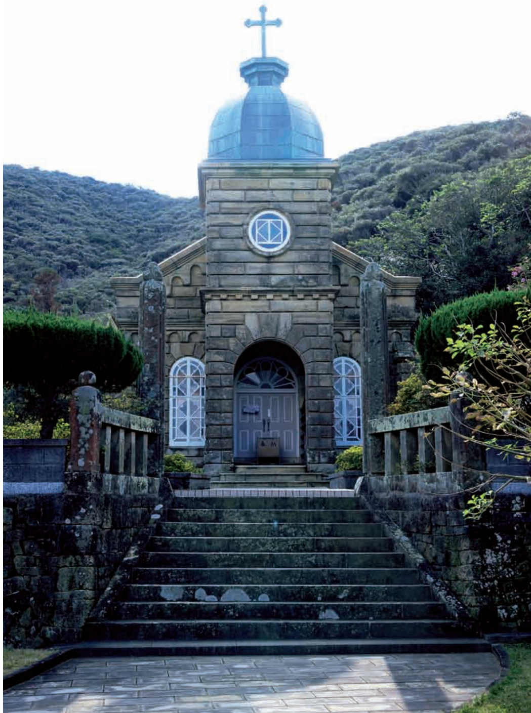
頭ヶ島教会（新上五島町、大正八年） 木造、鉄筋コンクリート、煉瓦造教会建築が多い中で、珍しい石造教会。設計・施工は鉄川与助。長崎県を中心に多くの教会建築を手がけた五島出身の棟梁建築家。日本の教会建築に多大な貢献をした。
