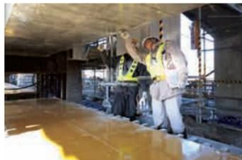
中主桁3カ所にそれぞれ6台のジャッキをセット、桁の変位を緻密に管理しながら持ち上げていく。
