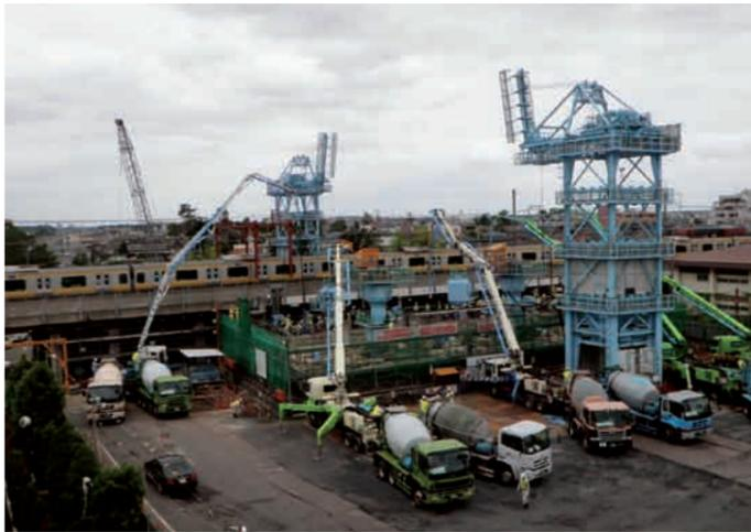
作業室の真上では函体本体を製作。函体を高さ5m構築するごとに沈降させる工程を3回繰り返す。(左右 写真提供：鉄建・オリエンタル白石JV)
