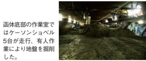
函体底部の作業室ではケーソンショベル5台が走行、有人作業により地盤を掘削した。
