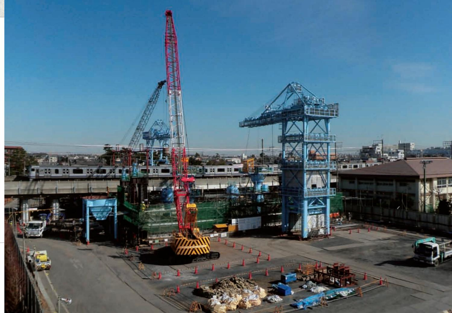
首都圏輸送の動脈ともいえるJR総武線に近接する現場。大型クレーン使用時には列車側にブームが必要以上に倒れないように、ストッパー機能をつけて作業を行った。(写真提供：鉄建・オリエンタル白石JV)
