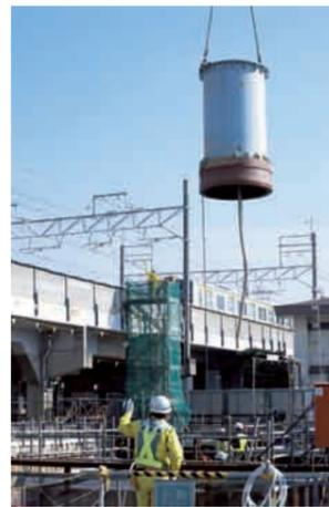
列車が接近すると列車見張員が誘導員に合図を出す。重機がピタリと動きを止める。
