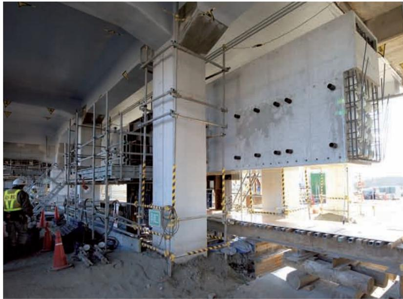
丸一日かけてジャッキアップされた中主桁。中主桁と横桁(黒い突起部に後日結合される)で既設高架橋を受け替える。
