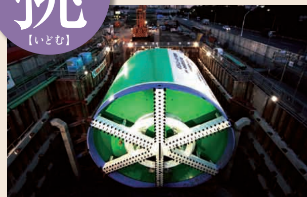
急速施工への挑戦 地上発進地上到達シールド URUP工法 株式会社大林組
