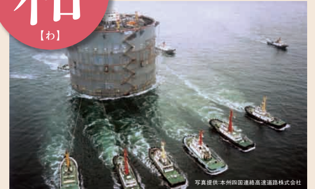
力の融和 明石海峡大橋
