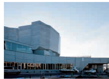
東側ファサード。外壁にはチタン亜鉛合金を含む材料が使われている。仕上りのイメージを設計者と共有してから施工された。
