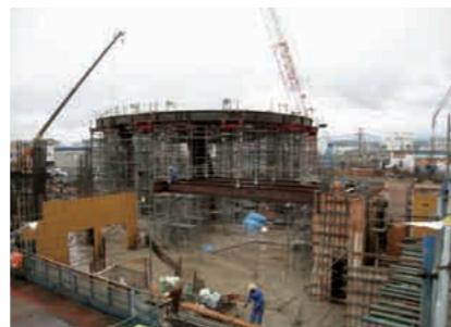
プラネタリウムの施工写真（平成22年3月20日時点）。鉄骨より下側を在来工法で、上側をトラスウォール工法で、それぞれコンクリートが打設された。 （写真提供：戸田建設）
