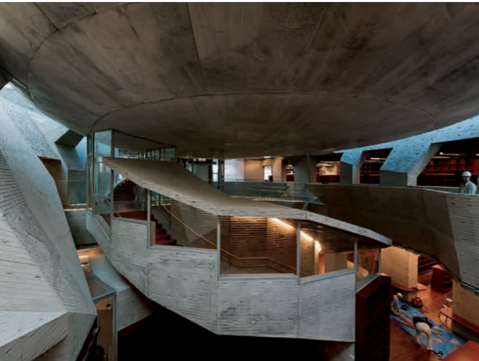
プラネタリウムの施工写真（平成22年3月20日時点）。鉄骨より下側を在来工法で、上側をトラスウォール工法で、それぞれコンクリートが打設された。 （写真提供：戸田建設）
