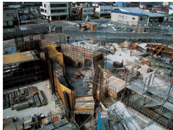
わいわいストリート（写真中央）を俯瞰した写真（平成22年5月18日の時点）。複雑な型枠工事の状況がよくわかる。 （写真提供：戸田建設）
