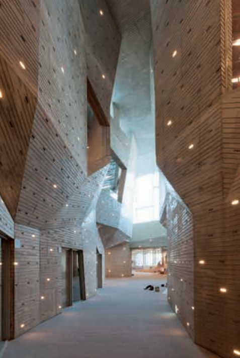
わいわいストリートのコンクリート壁面には、出目地加工が施されている。またビーコンには角座を採用し、LEDの照明も一緒に打ち込まれている。
