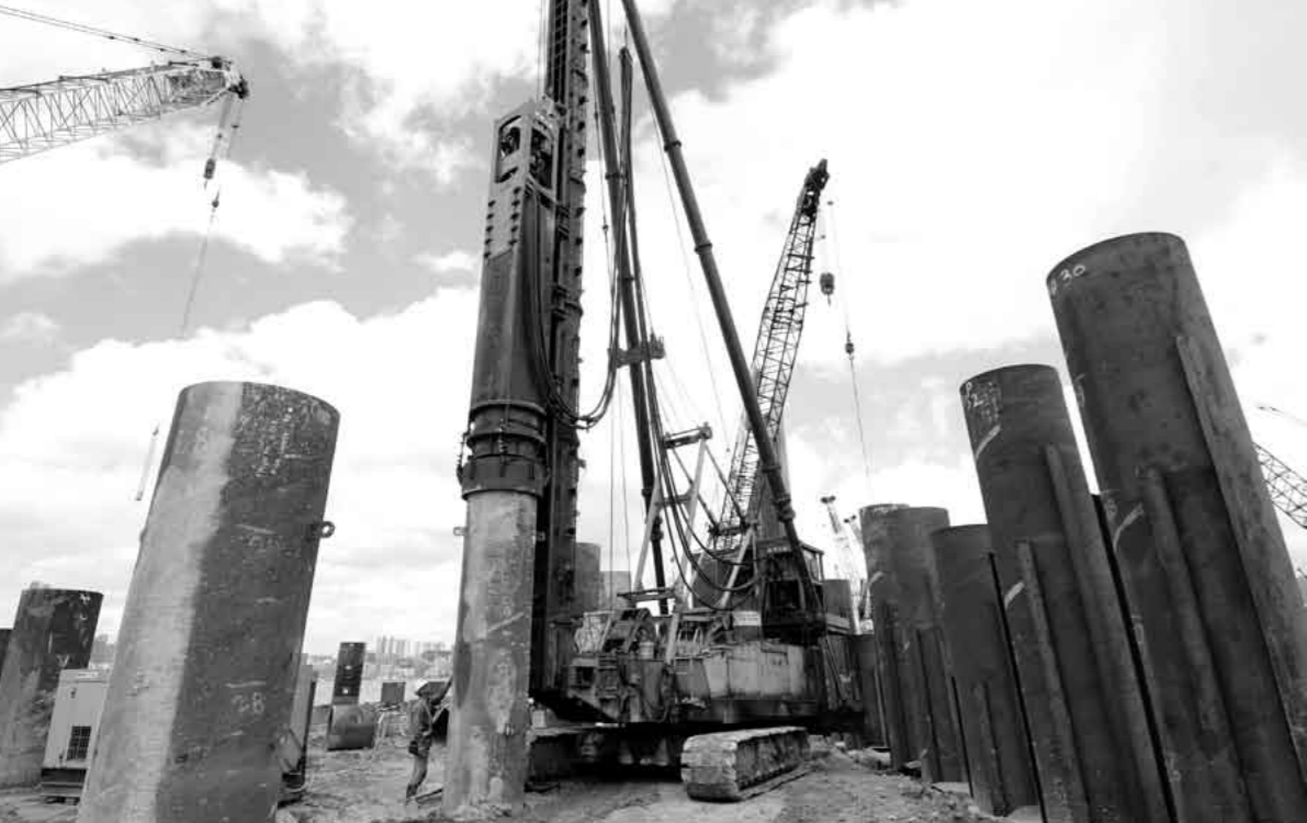
鋼管杭打設 (2010年8月23日撮影)
