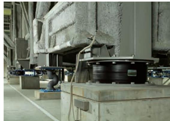
建物は免震構造(基礎免震)が採用され、地震からスパコン「京」を守っている。免震装置として積層ゴム支承(49カ所)および鉛ダンパー、鋼製U型ダンパーを設置。震度6強レベルの地震が起きても主要な機能が確保される。
