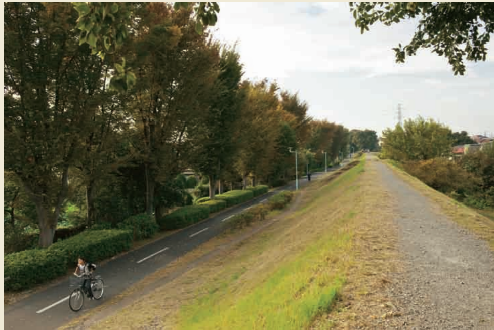
多摩湖から境浄水場に至る一直線に延びる水道の本管の上に、多摩湖水道道路は歩行者自転車道として登場した。
