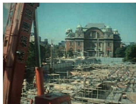
地下1階部分の施工風景。現場は常に張り詰めた空気であった。奥には中央公会堂が見える。
