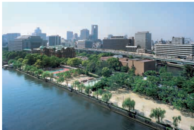
1999年増築直後の全景。土佐堀川(手前)と堂島川(奥)に挟まれて建っている。西側(左手)には中央公会堂や府立図書館など名建築が並ぶ。(※)
