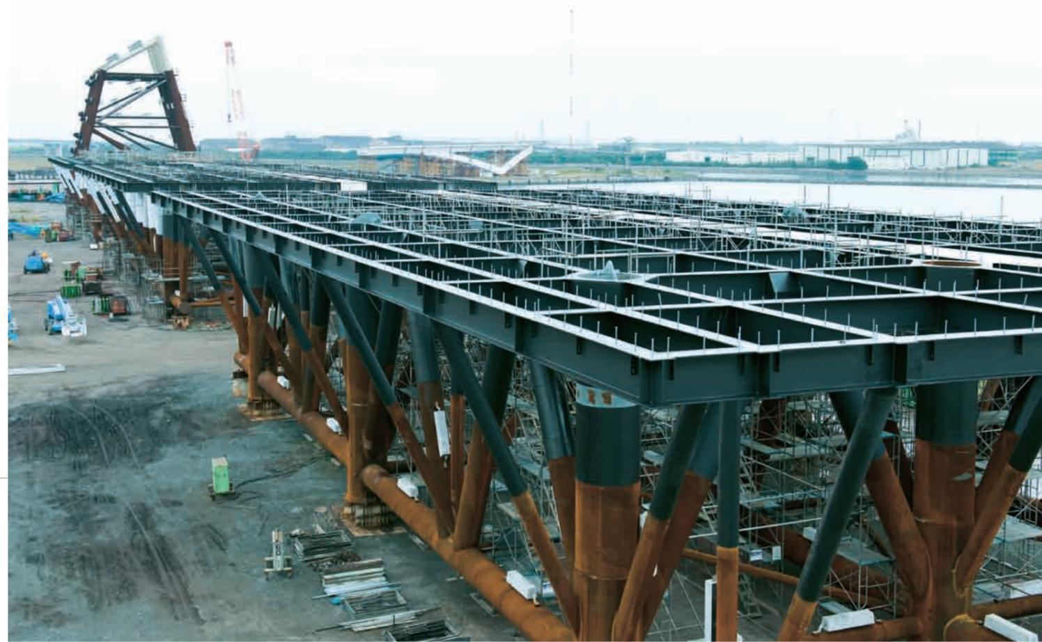
縦30m×横60m×高さ10.6m (509t～539t/基)の鋼製ジャケット3基を北九州で製作。那覇港の海上で連結し、客船ふ頭として整備される。
