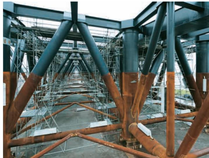
主要な鋼構造部材を陸上の工場で作成するため、安定した品質を確保できる。
