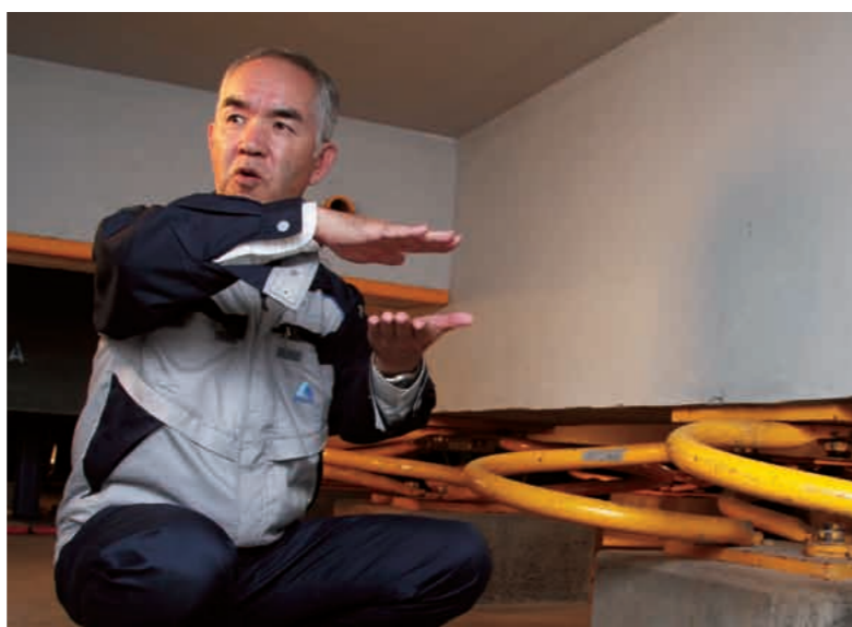
研究管理棟の免震層でコイル状の鋼棒弾塑性ダンパーの働きを解説する奥村組技術研究所建築研究課長・茂木正史さん。研究管理棟の免震構法の開発に携わった一人。
