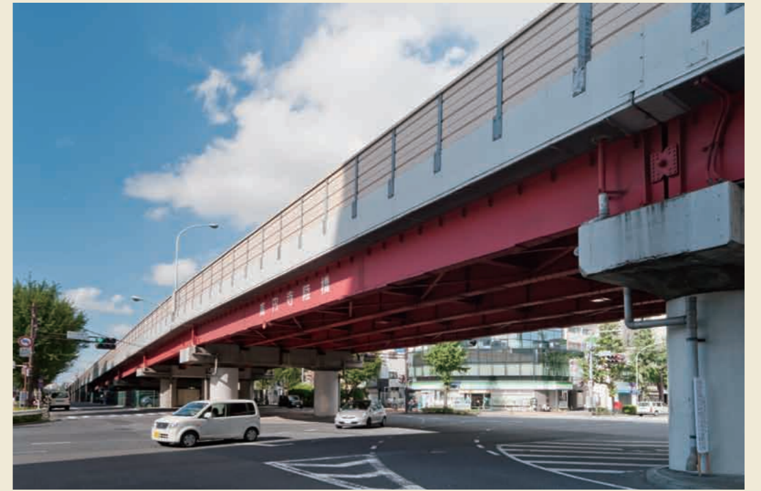
標準設計の橋桁が大量の交通を整流する高円寺陸橋。環七と青梅街道が交わる句読点。
