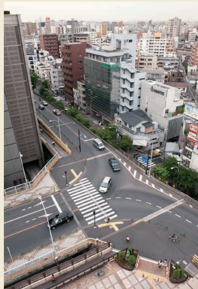
田端駅の西側の台地から陸橋を渡る と、T字交差点に行き当たる。交差 点そのものが高架橋の上にある、台 地と低地の高低差故の苦心作。
