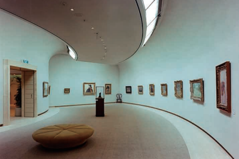
常設展示が行われている本館の展示室。3次曲面の展示壁は職人魂が高度に発揮されて入念に高品質に仕上げられた。
