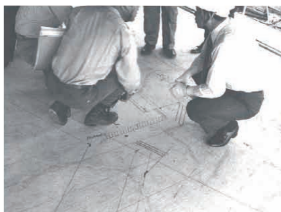
現場の様子。躯体・仕上げ・機器などを同時に墨入れし、円形建築ゆえの高い精度の確保に務めた。
