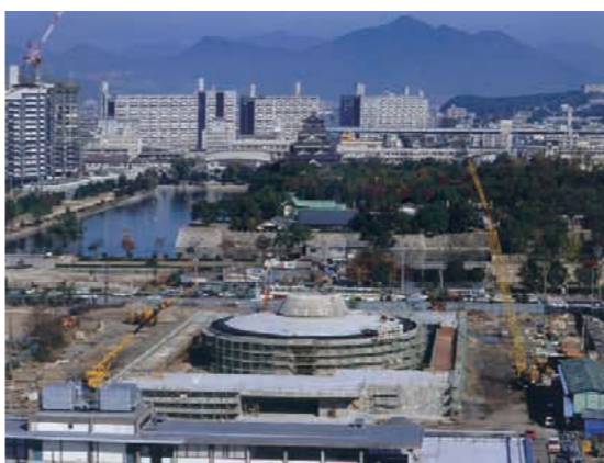
現場の様子。躯体・仕上げ・機器などを同時に墨入れし、円形建築ゆえの高い精度の確保に務めた。
