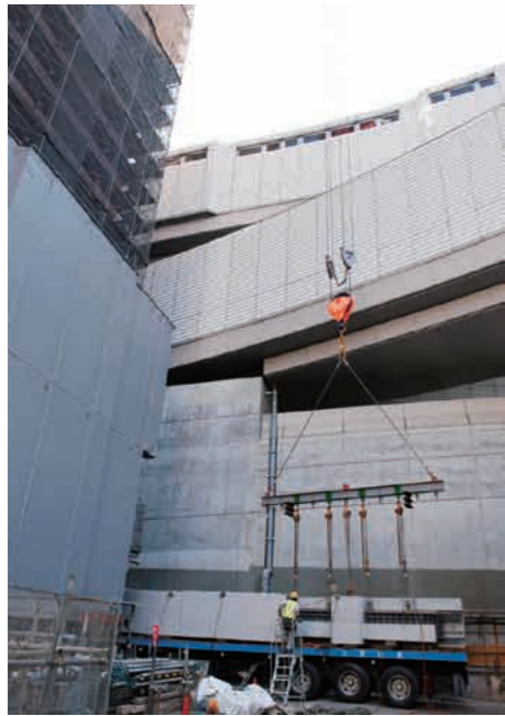
外装材であるタイルが埋め込まれた状態で搬入され、そのまま揚重されるプレキャスト部材。
