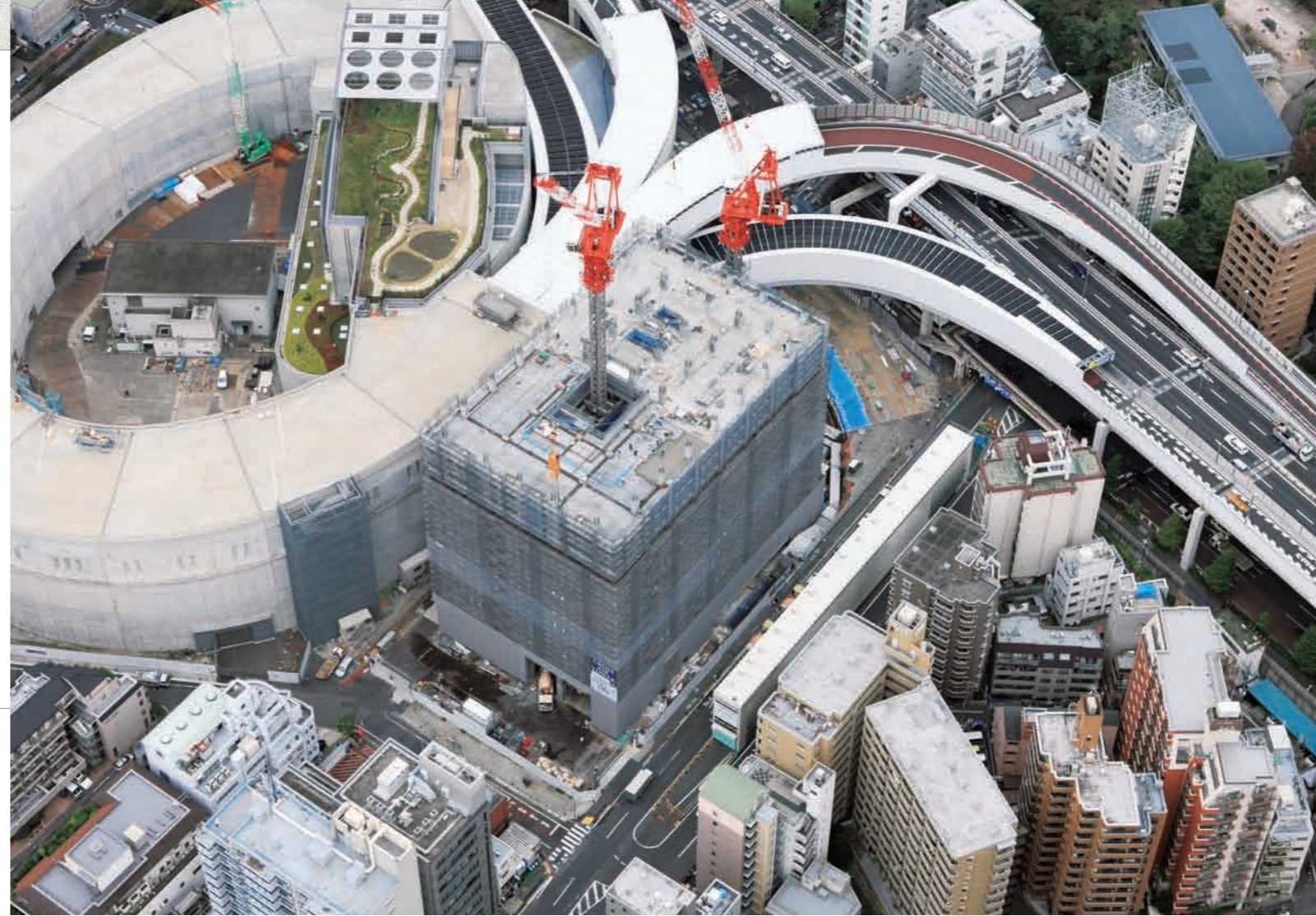
左側に大橋ジャンクション、右側には首都高(中央環状線と高速三号渋谷線)が位置し、写真中央に今回の現場が見える。(写真:SS東京)
