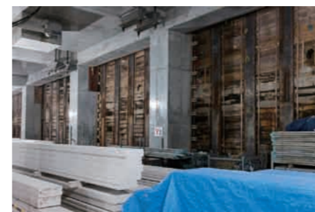
高層棟の地下階には、これから工事に着手する低層棟との山留仕切壁が露出している。
