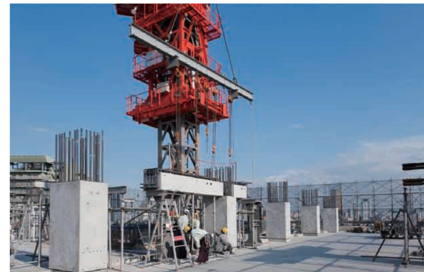
連結を待つプレキャストコンクリートで作られた柱と梁。
