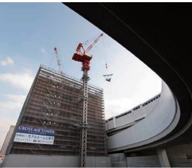
国道246号から建物を見る。頭上には首都高速が走る。
