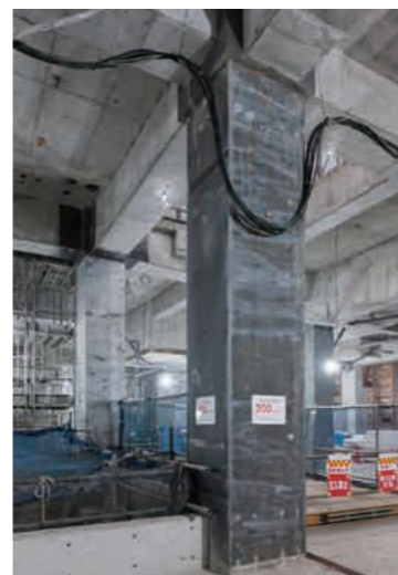
FC200の強度をもつプレキャストコンクリート柱。日本で初めて実施工された。
