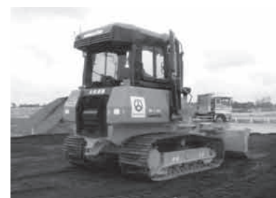
10tブルドーザによる土砂撤出し(30cm/層)、敷均し
