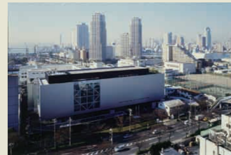
清水建設技術研究所新本館 発表者：神作和生氏（清水建設）
