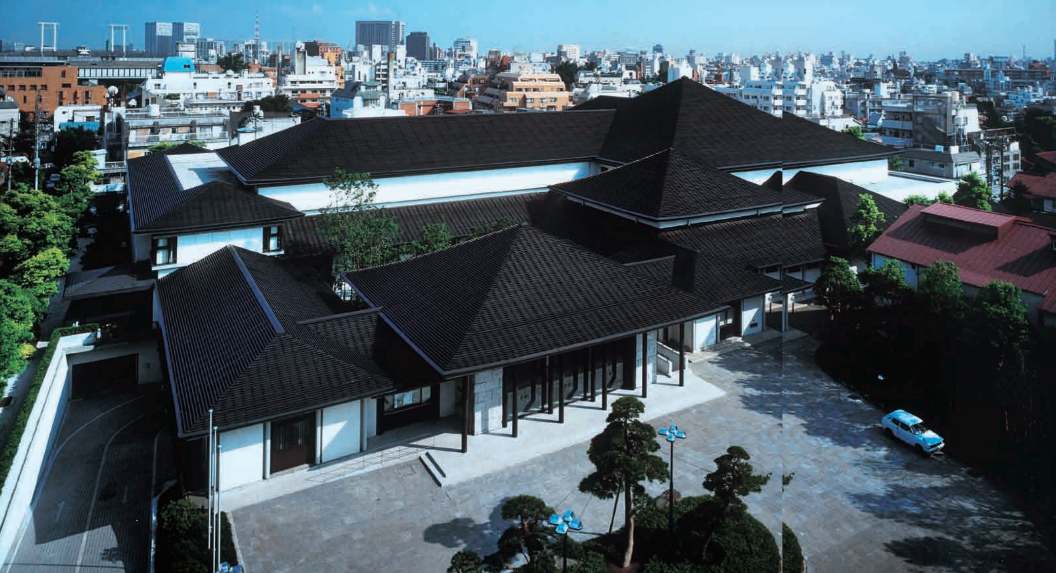
全景。細かく分節された屋根が重なり合う。屋根はアルミ角材のルーバー。
