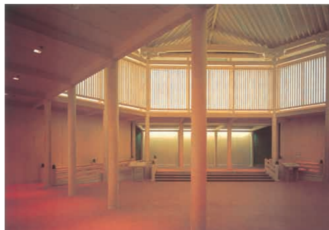
広間。変五角形平面に13本の円柱が並ぶ。上部の障子と縦格子によるスクリーンの光に包まれている。
