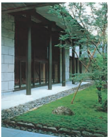
中庭から玄関広間をみる。6本の耐候性鋼板の丸柱が方形屋根の化粧桁を受ける。
