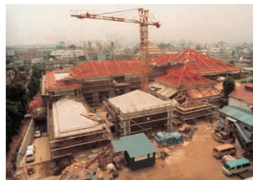
屋根工事の様子。優美な曲線をもつ屋根は鉄骨でかたちづくられている。
