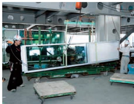
エレベーターで発射階まで運ばれた外装ACW。移動用の台車に乗せかえて、各設置準備位置まで人力で移動する。
