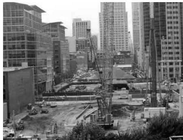
工事写真(敷地全景)
