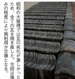
昭和の大修理では瓦の劣化が激しかったため、全ての瓦を焼き直した。今回は傷みの程度により再利用か交換となる。
