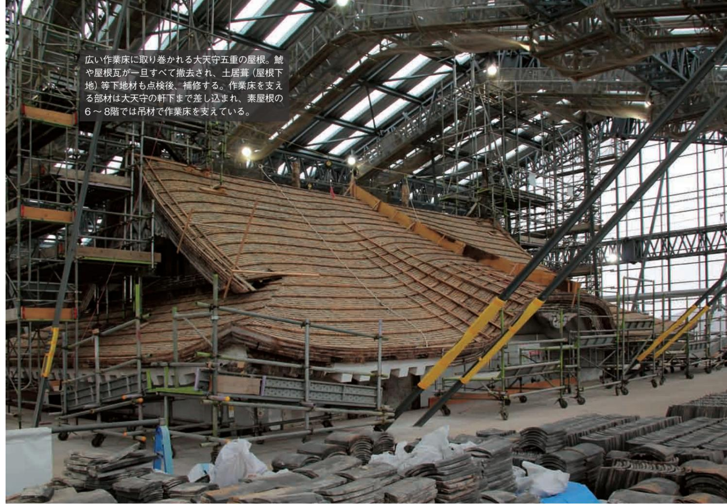
広い作業床に取り巻かれる大天守五重の屋根。鯨や屋根瓦が一旦すべて撤去され、土居葺(屋根下地)等下地材も点検後、補修する。作業床を支える部材は大天守の軒下まで差し込まれ、素屋根の6~8階では吊材で作業床を支えている。
