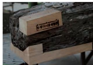
部材の修繕。腐朽などが進んだ部分を削り、新材を継ぎ再利用する。こうした修繕は昔から行われてきた。修理をほどこした部分には刻印がうってある。
