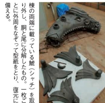
棟の両端に載っている鯨(シヤチ)を取り外し、胴と尾に分解したもの。一枚ごとに外周をなぞって型紙をとり、復元に備える。
