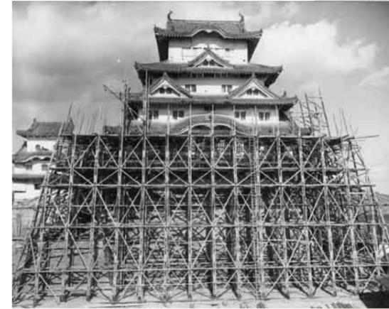
昭和の大修理の素屋根建設中の様子。風速40mにも耐える設計とするため、真っ直ぐなヒノキ丸太を厳選し、直径4寸に加工。抱き合わせ柱複合組みにより建ち上げた。(写真提供：姫路市立城郭研究室)
