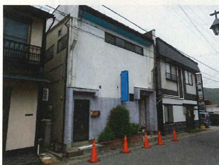
外壁落下建物全景
