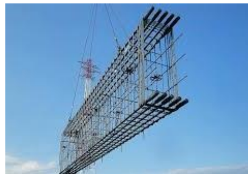
梁鉄筋地組取付
