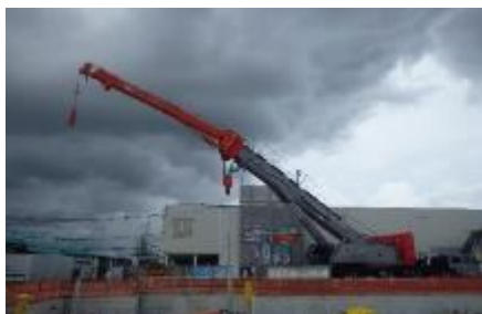
ラフタークレーンによる施工
