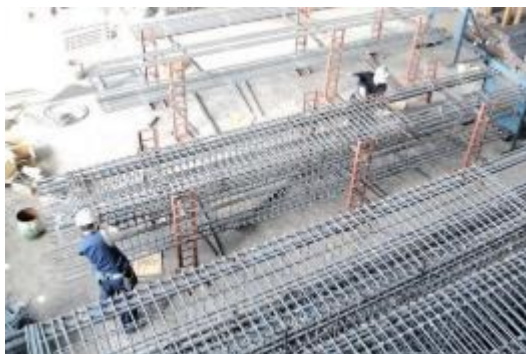
梁鉄筋工場地組
