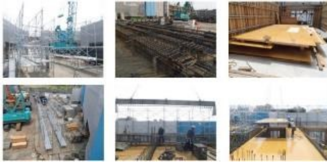
地組(足場・型枠・鉄筋)のイメージ
