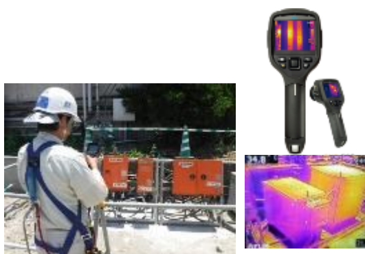
サーモグラフィーの活用
