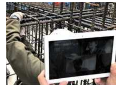
Webカメラを利用した遠隔検査
