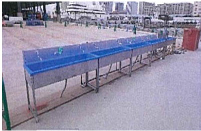
現場の手洗い場所の増設
