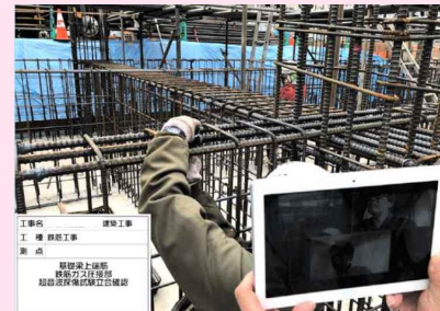
Webカメラを利用した遠隔検査
