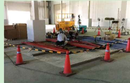
工事エリアの区画を設定して作業
