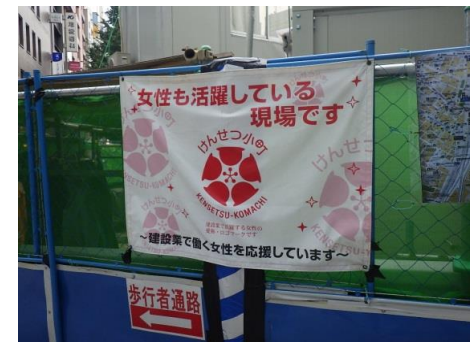
近隣向け垂れ幕を設置しています
