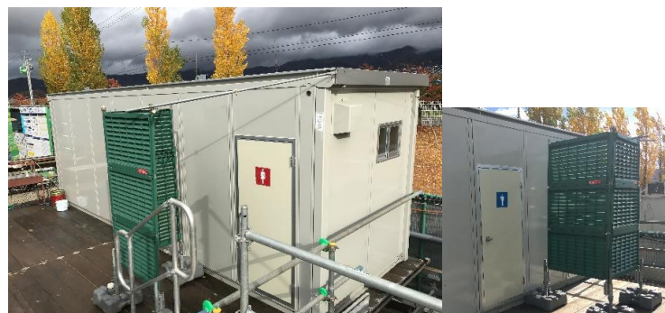
女性専用のトイレ(パーテーション付・二重扉)
