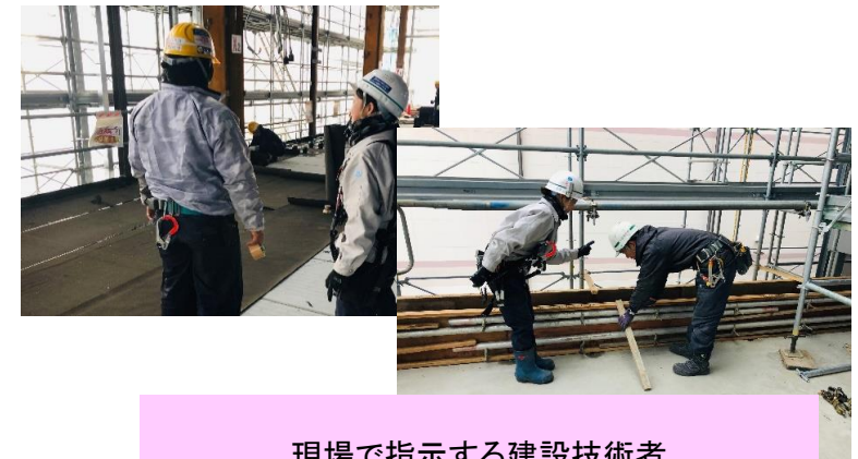
現場で指示する建設技術者
