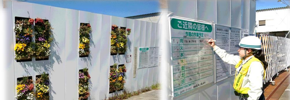
仮囲いパネル 草花を植栽し周囲を明るくしています
