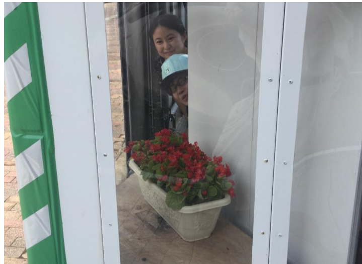
⑤仮囲いのコーナーにクリアフラットパネル&花の設置
