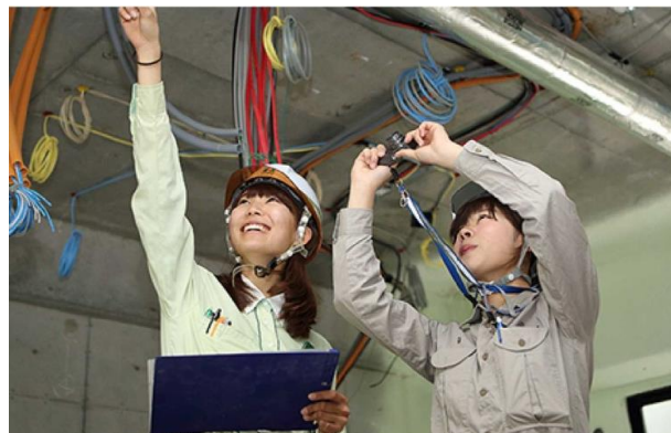
⑤設備配管チェック
