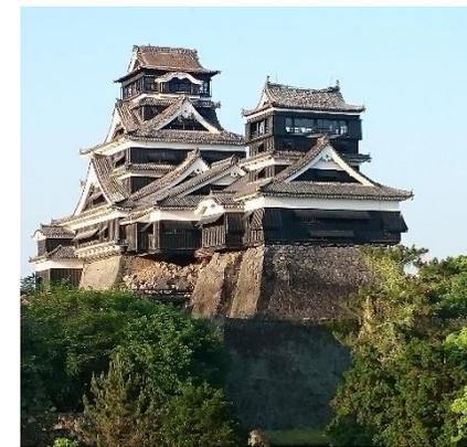
熊本地震による熊本城の被害
