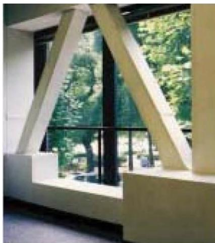
【低降伏点鋼鉄骨ブレース】
