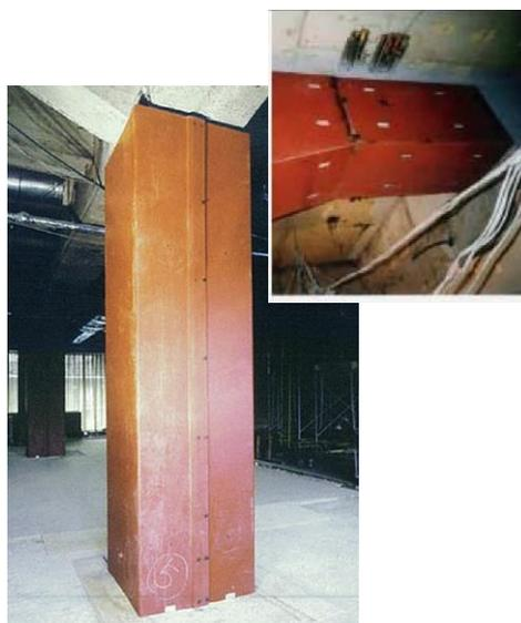
鋼板による柱・梁の補強
