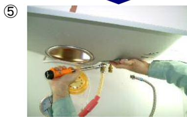
⑤ シンクをカウンターに固定し、シンク下配管の接続を行う。
