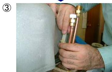
③ 専用取付工具にて馬蹄金具締付ける。カウンター補強が十分に乾いていること。
