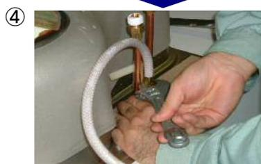
④ 浄水器等の付属ホースを取付ける。専用固定工具は竣工後も取付けた状態が良い。
