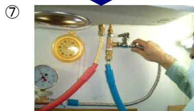
⑦ 丘組みした三方分岐をシンク下配管に固定する。
