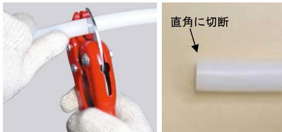
樹脂管カッターを用いて、架橋ポリエチレン管の管軸に対して直角に切断する
