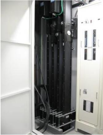
シャフトスターはアルミニウムの帯状導体を絶縁物で被覆しアルミニウム押し出し成型品のケースにおさめたものである。
