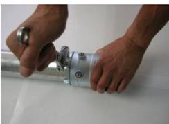
・ 管を挿入しサイドの締付ナットのハブにモンキーレンチを架け本体を押さえた状態で、モンキーレンチが止まるまで廻す。<br/>(本体内部の防水パッキングが密着する)</p> <p>④
